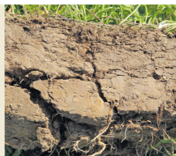
Eine plattige Struktur im Oberboden ist ein sichtbares Anzeichen für Bodenverdichtung.
