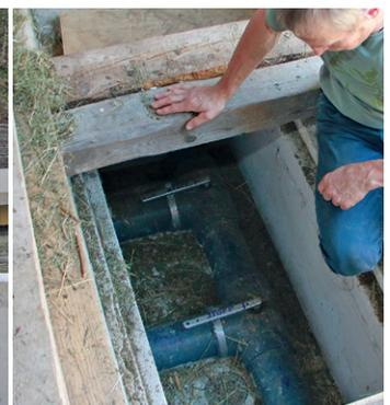
**EIN AUSGEKLÜGELTES GÜLLESYSTEM** spart Kosten und hält Technik und Geruch im Zaum. Jeder Kanal kann einzeln gespült werden.
