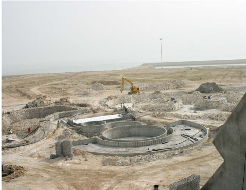
Neubau einer Hotelanlage
